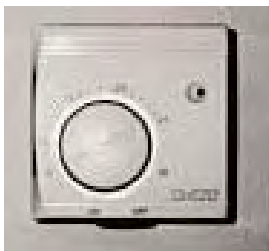
Χειροκίνητος θερμοστάτης χώρου.
